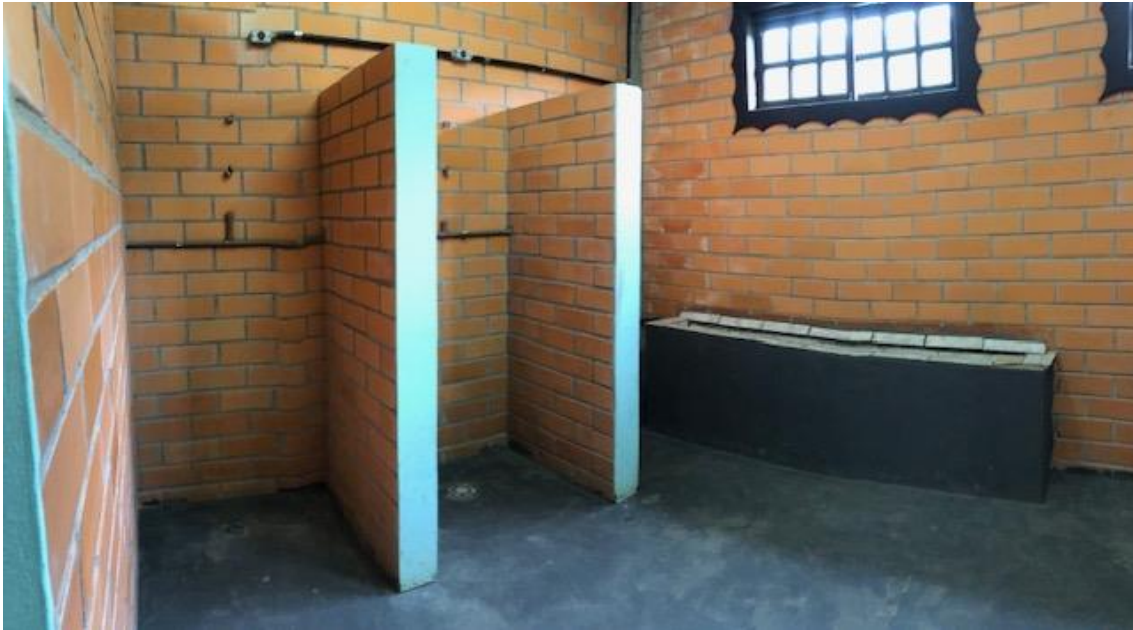
Foto 14 – Paredes e mictório a serem removidos
