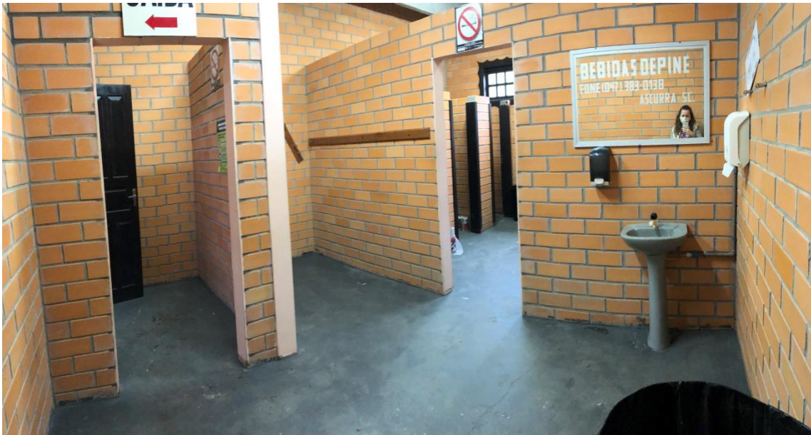
Foto 11 – Ao centro da foto será instalado um sanitário PCD
