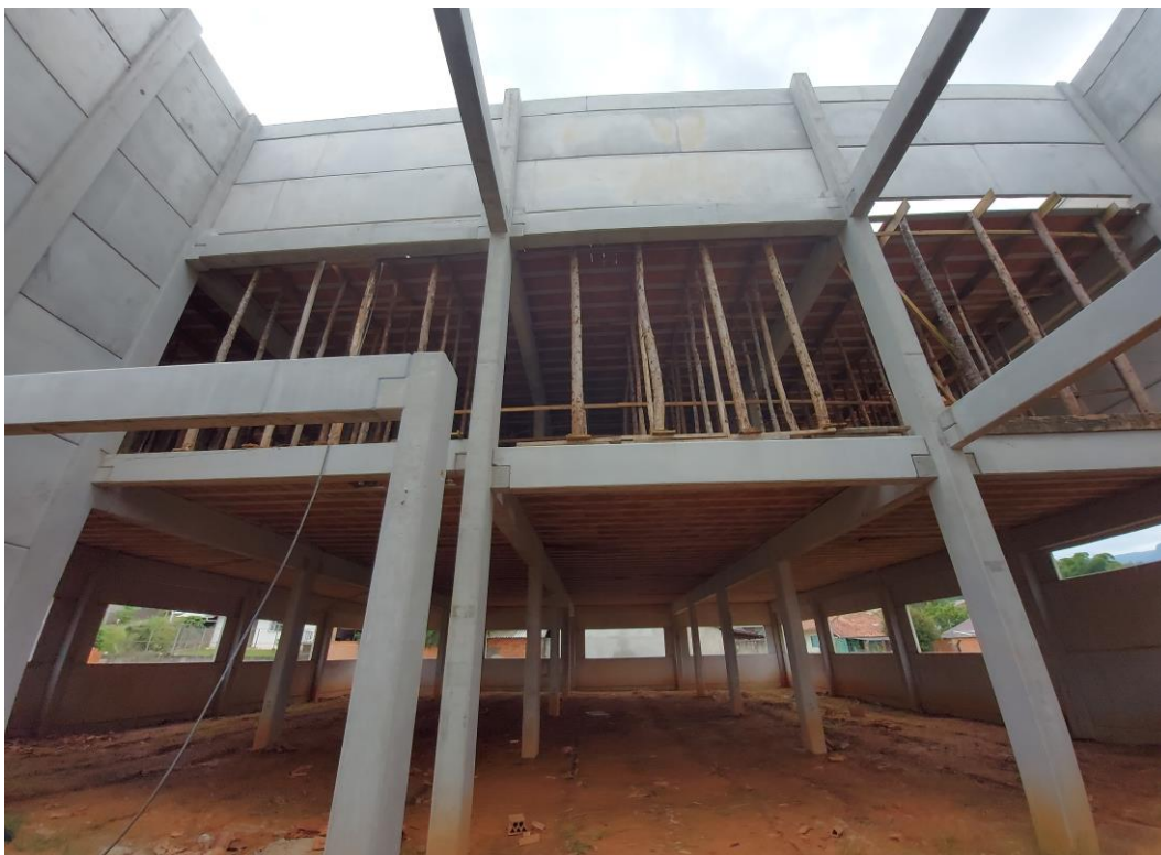
Imagem mostrando a recepção da edificação, local onde devem ser instaladas as lajes.
