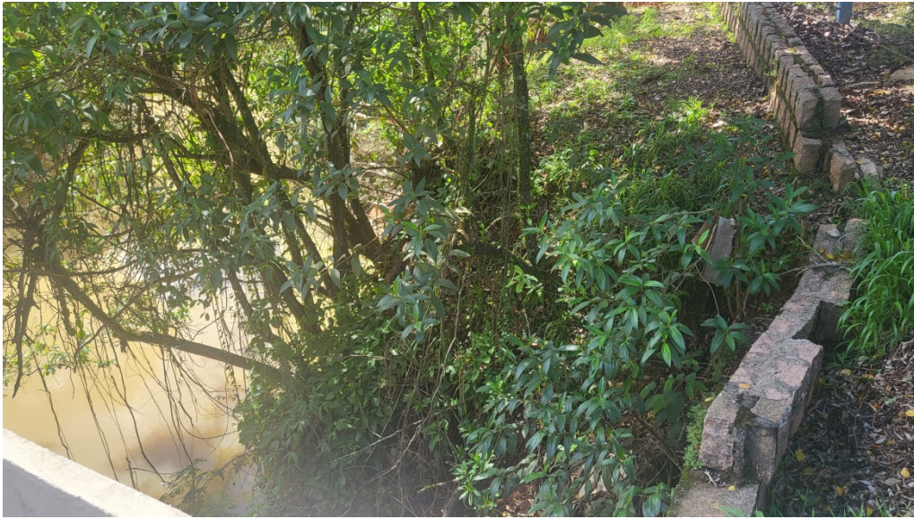
Foto 05 – imagem do ribeirão e cabeceira da ponte (muro de pedra existente).
