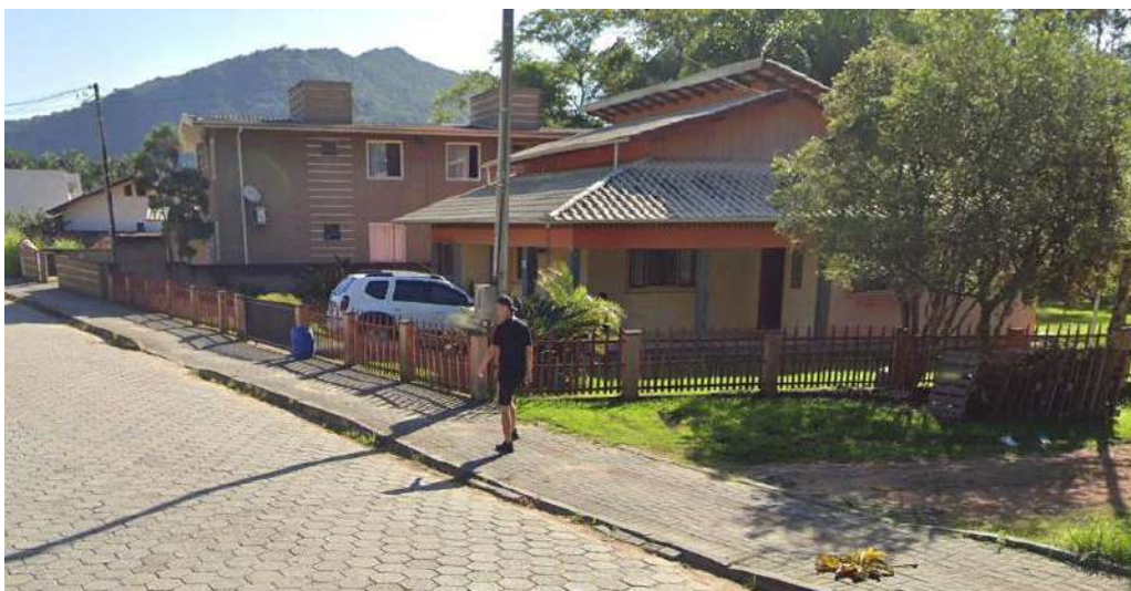
Imagem 14: Edificação Unifamiliar localizada na Rua Indaial, em frente ao empreendimento.
