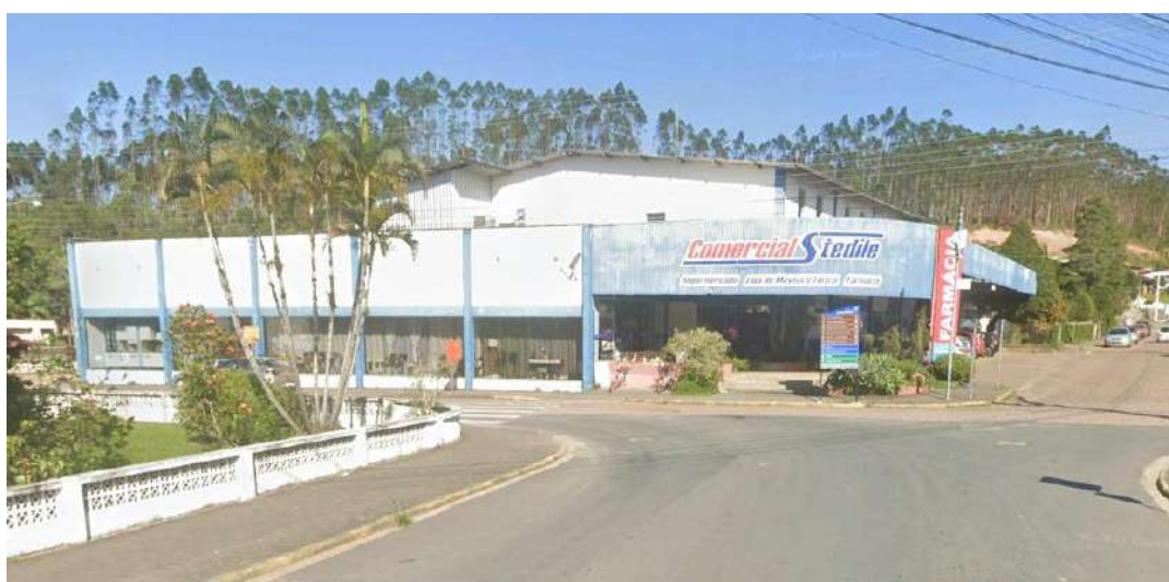
Imagem 17: Edificação Comercial localizada na esquina da Rua Indaial com a Rua Prof. Francisco Stedile, próximo ao empreendimento.
