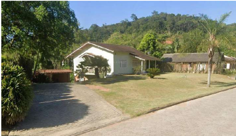
Imagem 12: Edificação Unifamiliar localizada na Rua Indaial, em frente ao empreendimento.
