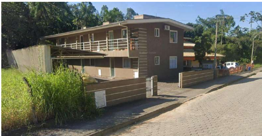
Imagem 15: Edificação Multifamiliar localizada na Rua Indaial, em frente ao empreendimento.
